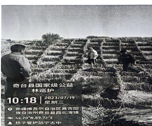
沙障工程正在施工中
